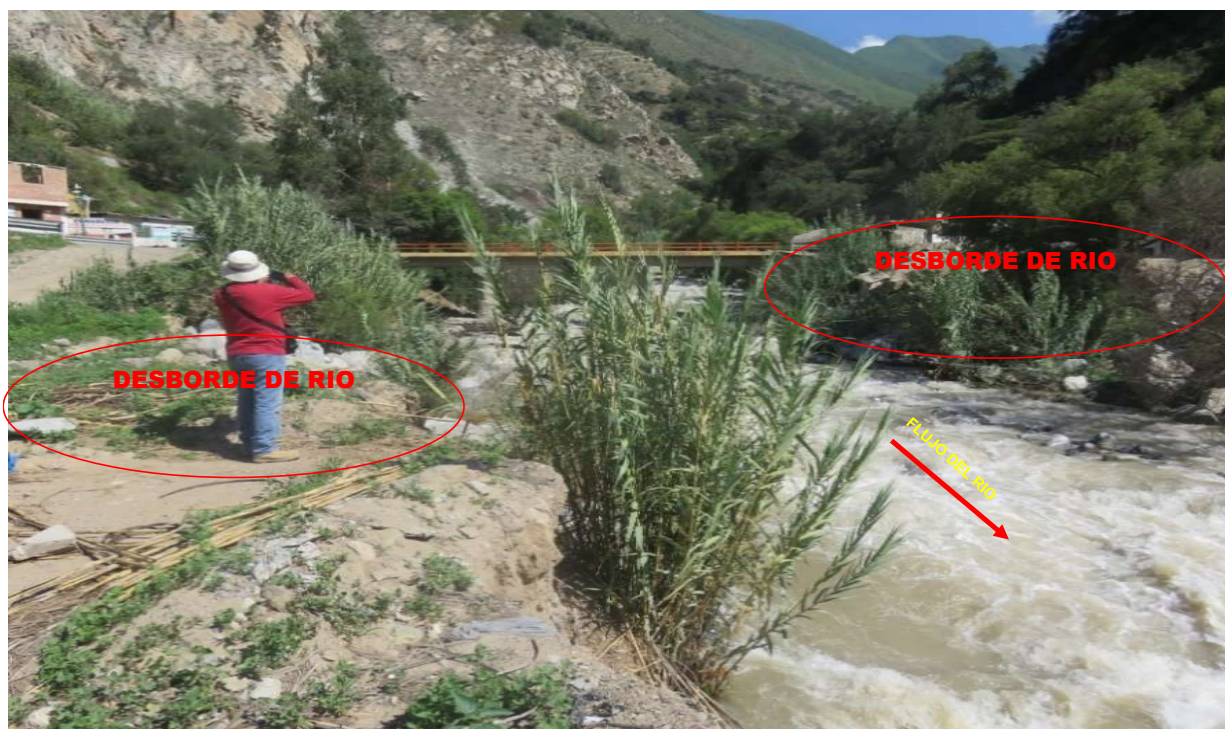
FIGURA N°02: MATERIAL COLMATADO EN EL CAUCE DEL RÍO CARAC, CON UNA PROFUNDIDAD PROMEDIO DE 1.0 M. ESTO PROVOCA QUE DESBORDAMIENTO DEL RÍO SEA MAS INMINENTE.
